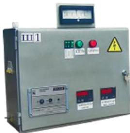
Работой горелки управляет автоматика блока управления. Блок управления горелкой представляет собой металлический электрический шкаф размерами 550 x 450 x 220 мм, весом не более 6 кг, с передней открывающейся дверкой.
