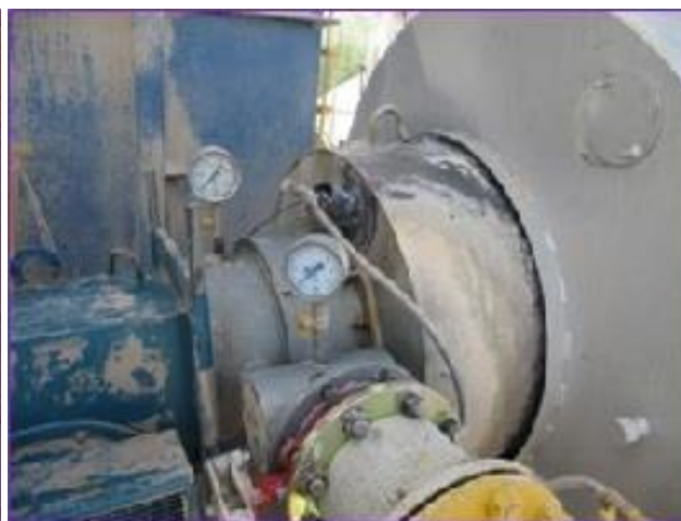
Рисунок 2. Горелки ГСАУ-Б на объектах эксплуатации
