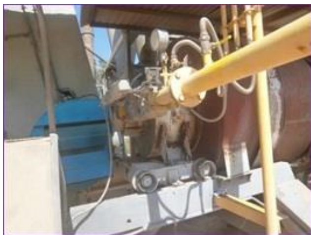
Рисунок 2. Горелки ГСАУ-Б на объектах эксплуатации
