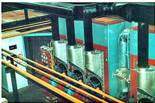
Рисунок 4. Горелки ГСАУ-Б на объектах эксплуатации
