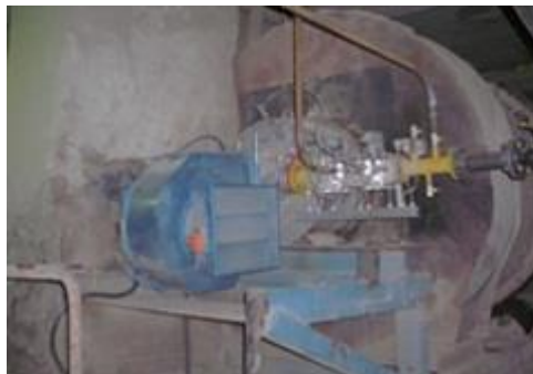
Рисунок 4. Горелки ГСАУ-Б на объектах эксплуатации
